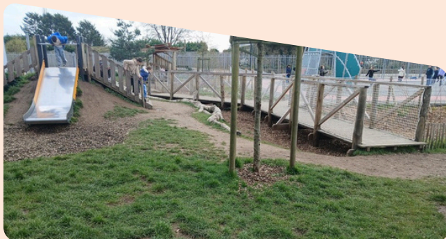
Passerelle au-dessus de la noue d'infiltration
