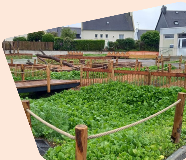
Une noue végétalisée et le pont
