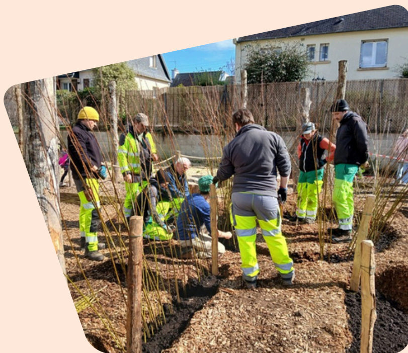
La construction des cabanes
