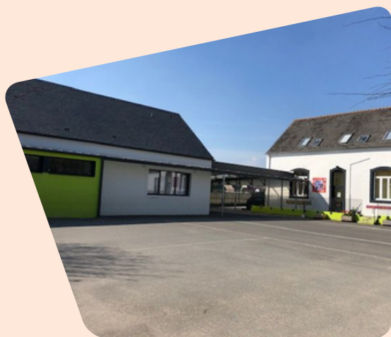
La cour avant les travaux
