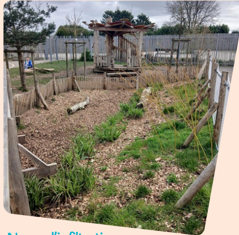
Noue d'infiltration
