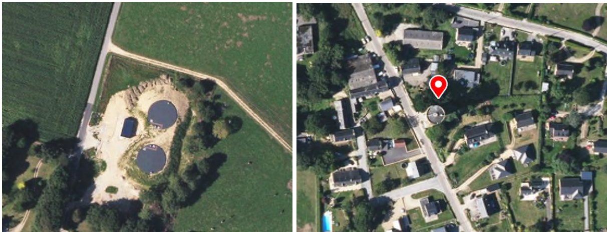
Figure 4 : Vue aérienne des réservoirs de Kerguéro à Brec'h (à gauche les bâches au sol et à droite le château d'eau)
