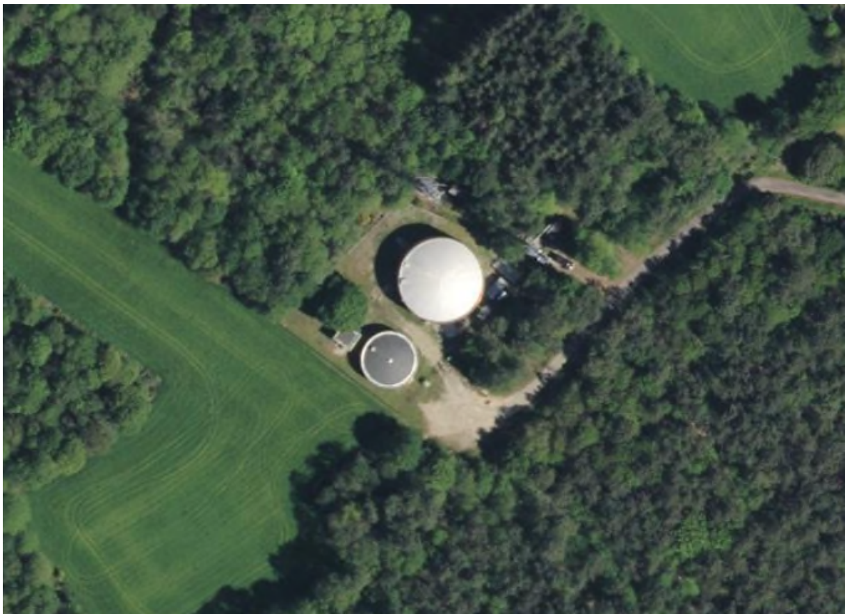
Figure 3 : vue aérienne des réservoirs de Kerpolican
